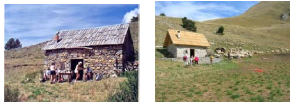
Cabane du vallon, alpage de Famouras commune de Méolans Revel, avant et après travaux
